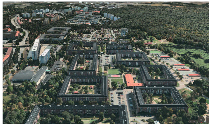
Fig. 3. Biskopsgården byggdes 1955-1966. Bild: Kartor.
