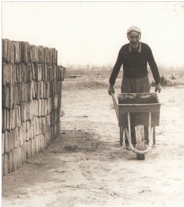
Studentprojekt 1987: Vi har rest stommen till gemensamhetshuset och gjuter golvet. Don Juan – en av Brandsens äldsta invånare – är alltid med och arbetar. En av invånarna visade sig vara bra på putsarbete och ledde arbetet med att göra en fin infärgad cementyta som ytskikt på golvet. Foto: Stenberg & Kain.
