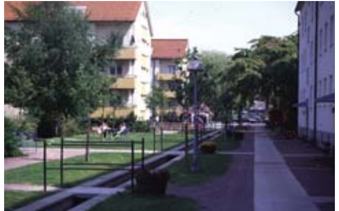
Bild 185. Ny markbehandling och dagvattenkanaler. Foto: Sonja Vidén.
