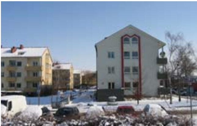
Bild 186. Några av femtiotalshusen har varsamt rustats upp utvändigt. Foto: Jenny Stenberg.
