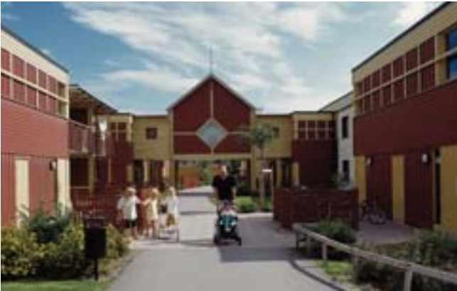
Bild 128. Området hade redan tidigare rustats upp och då kom dessa mellanbyggnader i trä till. Foto: Jenny Stenberg.
