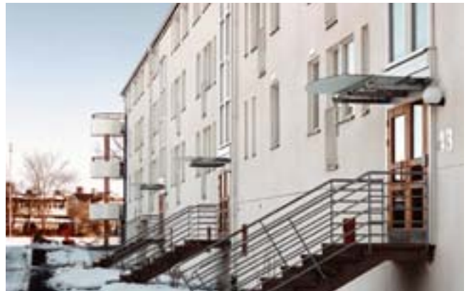
Bild 51. Nya entréer öppnades mot p-platserna på baksidan. Foto: Petter Koubec.
