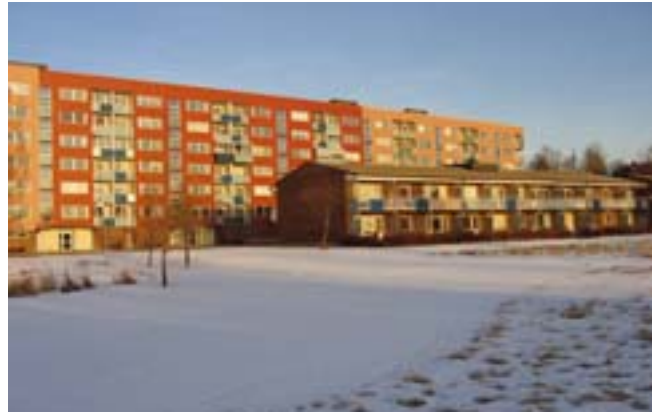
Bild 11. Efter åtgärden har höghusen fått ny färg. Foto: Jenny Stenberg.
