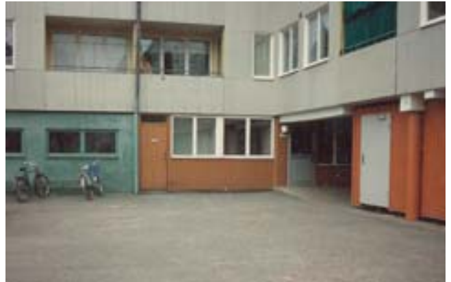
Bild 49. En entré innan projektet genomfördes. Foto: PA Strömberg.
