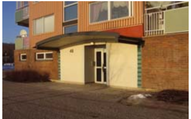
Bild 13. Entréerna har byggts om. Foto: Jenny Stenberg.
