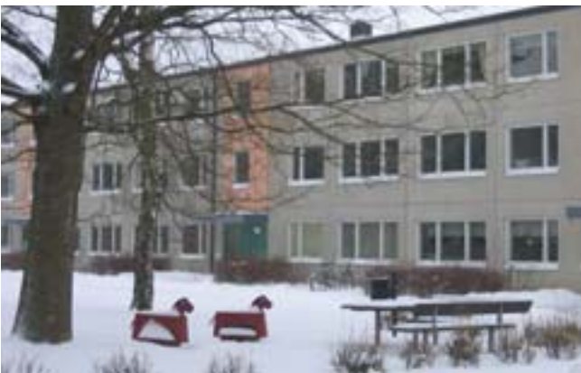
Bild 130. Fasaderna målades vid entréerna och men i övrigt lämnades de orörda. Det pågår dock en sanering av fogarna. Foto: Jenny Stenberg.
