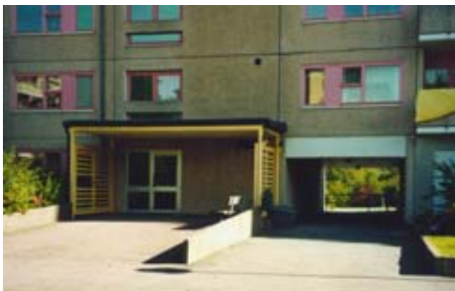
Bild 105. En entré innan ombyggnaden. Foto: Lasse Johansson.
